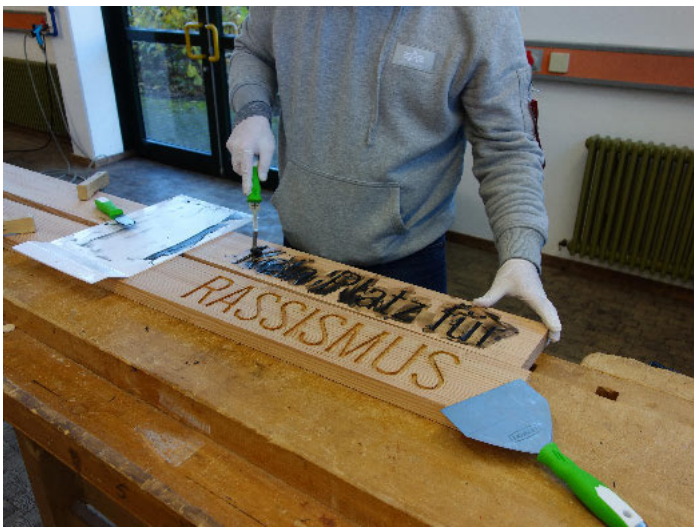
/ Durch Zugabe von maximal 2 % Farbpigment (Mixol) lässt sich die Reparaturmasse einfärben und mittels Spachtel in die Vertiefungen des Schriftzuges einarbeiten.
